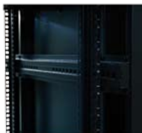
Montants ajustables Guide câbles verticaux pour les largeurs 800
